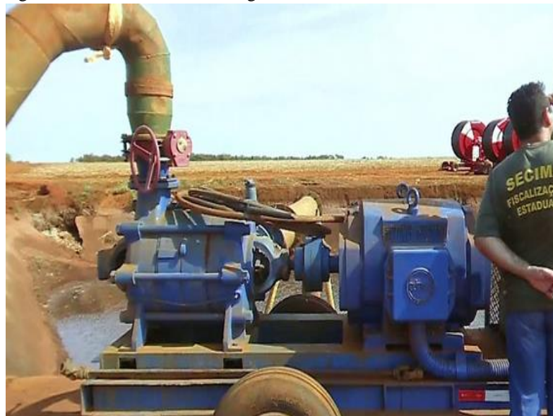
Figura 03 – Bombeamento das águas do Rio das
