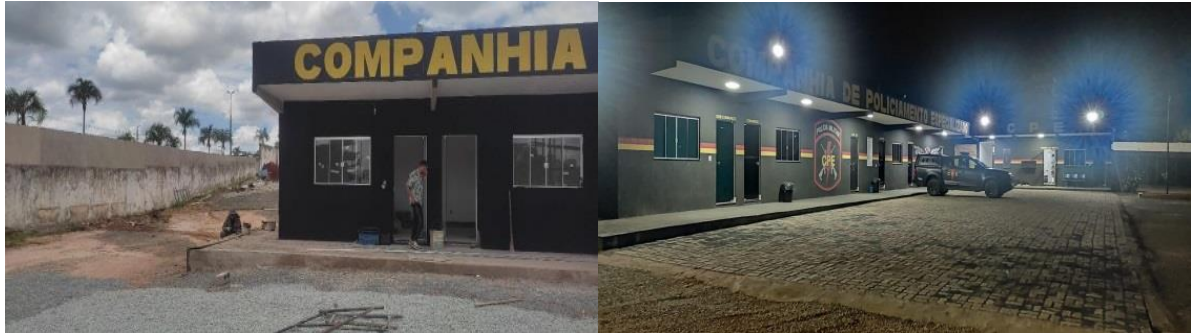
FIGURA 6: ACABAMENTO E PAVILHÃO PRINCIPAL FINALIZADO
