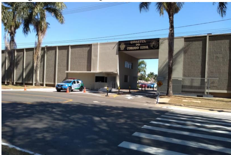
Figura 4: Fachada do Quartel do Comando Geral
