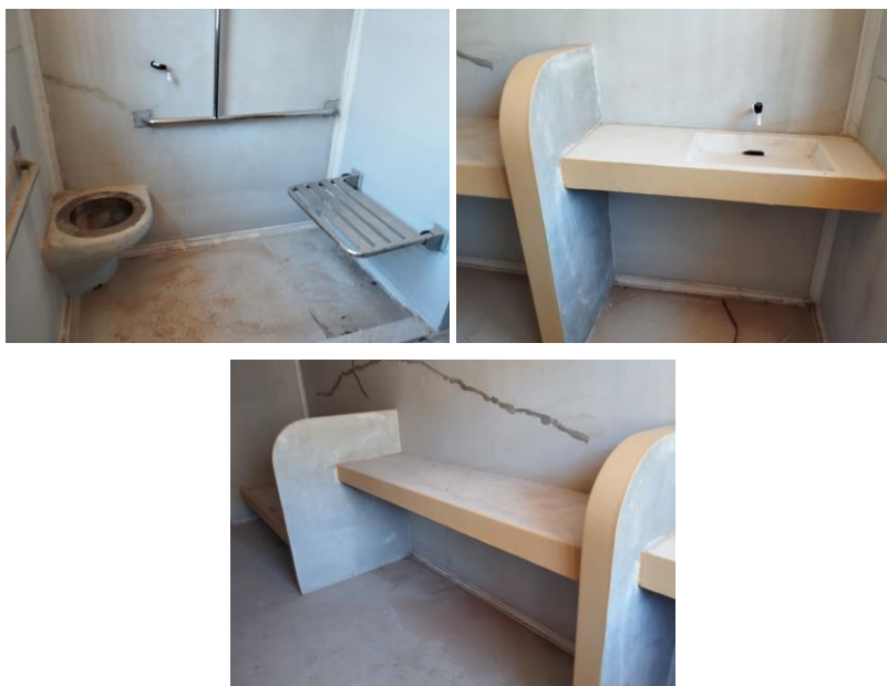
Figura 5 – Cella acessível em obra na nova estrutura da Penitenciária Odenir Guimarães
