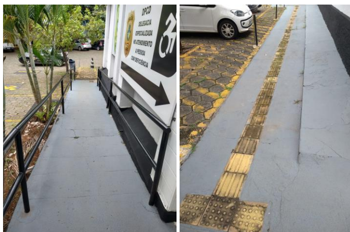
Figura 3 – Piso tátil e rampas
