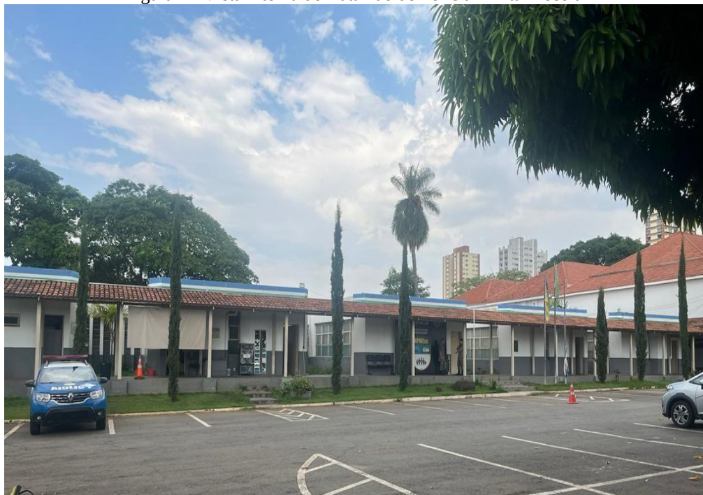
Figura 1 - Vista interna do Batalhão de Polícia Militar Escolar
