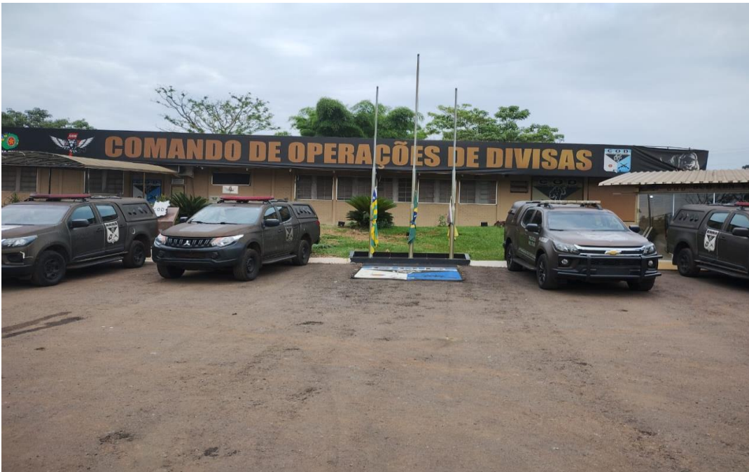
Figura 2: Frente da Estrutura do COD em Goiânia (GO)
