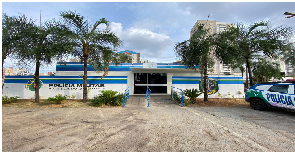
Figura 4 – Estacionamento e Entrada do Batalhão
