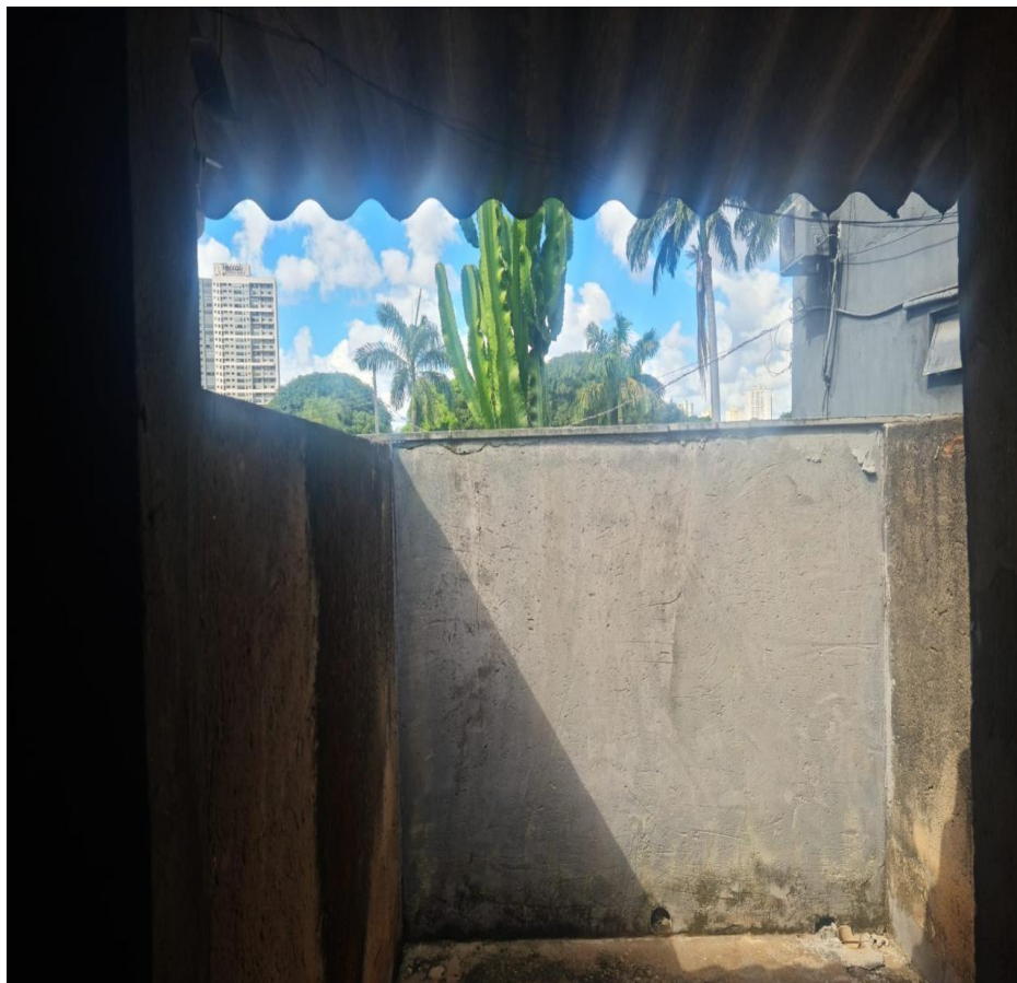
Figura 1 - Box não ventilado e sem visão externa no BPCÃES
