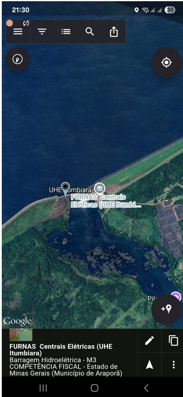
Imagem 5 - Edificação Usina Hidrelétrica
