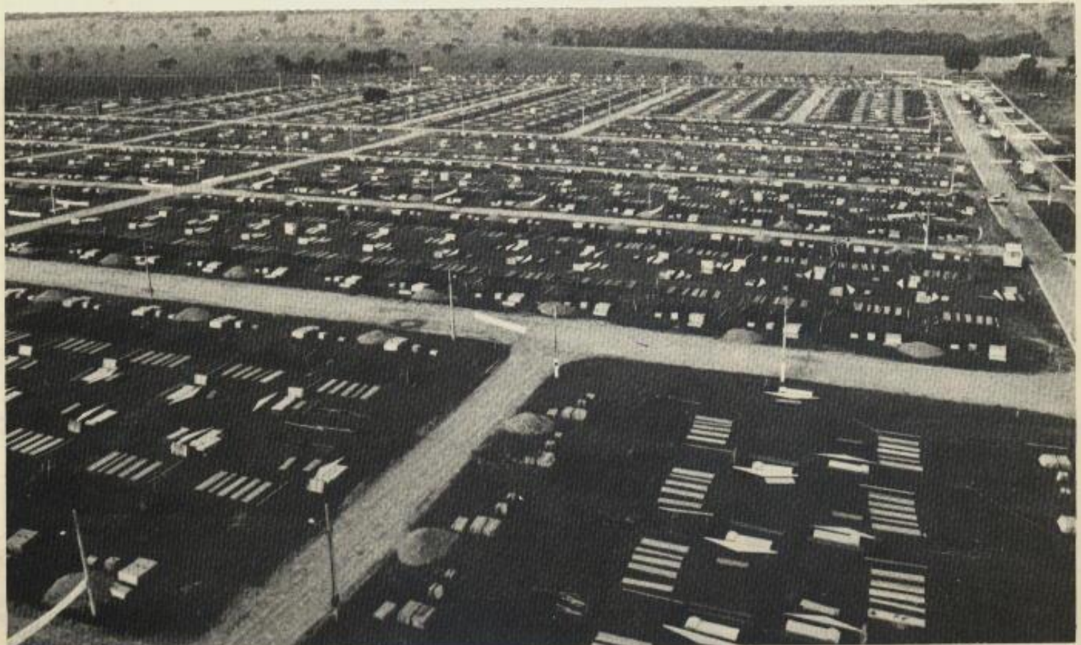
O canteiro de obras, antes do trabalho de construção das 561 casas
