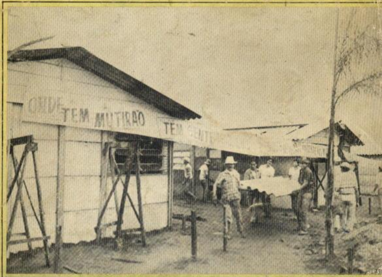
O canteiro de obras, antes do trabalho de construção das 561 casas
