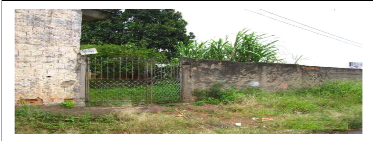
Figura 11: Casa abandonada. Rua 02 Qd. 02 Lt 19, Setor Universitário. No local conforme averiguação está sendo utilizado como ponto de usuários de drogas e contraventores da lei, servindo como ponto de esconderijo de meliantes que escondem materiais de furto e roubo no local, conforme relato dos moradores da região, existe a sensação de desconforto e receio em deixarem suas residências sozinhas.
