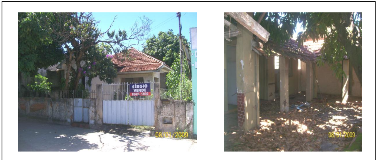
Figura 02: Casa abandonada. Av. Paranaíba N° 495 prox. esq. com Av. Araguaia, Setor Central. Local serve de abrigo para usuários de drogas e moradores de rua. Os vizinhos relatam que é frequente a presença de estranhos no local, durante a noite entram no imóvel e invadem os lotes vizinhos para furtar.
