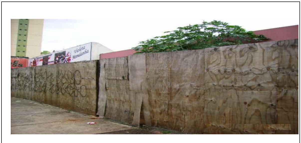
Figura 14: Casa abandonada. Rua 94 n° 456, SETOR SUL, ao lado de uma academia de musculação. Neste local conforme declarações de trabalhadores dos estabelecimentos comerciais e moradores da região se encontra abandonada há algum tempo e que a mesma está sendo utilizada por moradores de rua que passam a noite no local consumindo drogas e bebidas alcoólicas, declaram ainda que várias pessoas no período noturno já foram furtadas nas redondezas por conta das aglomerações desses infratores da lei no local.
