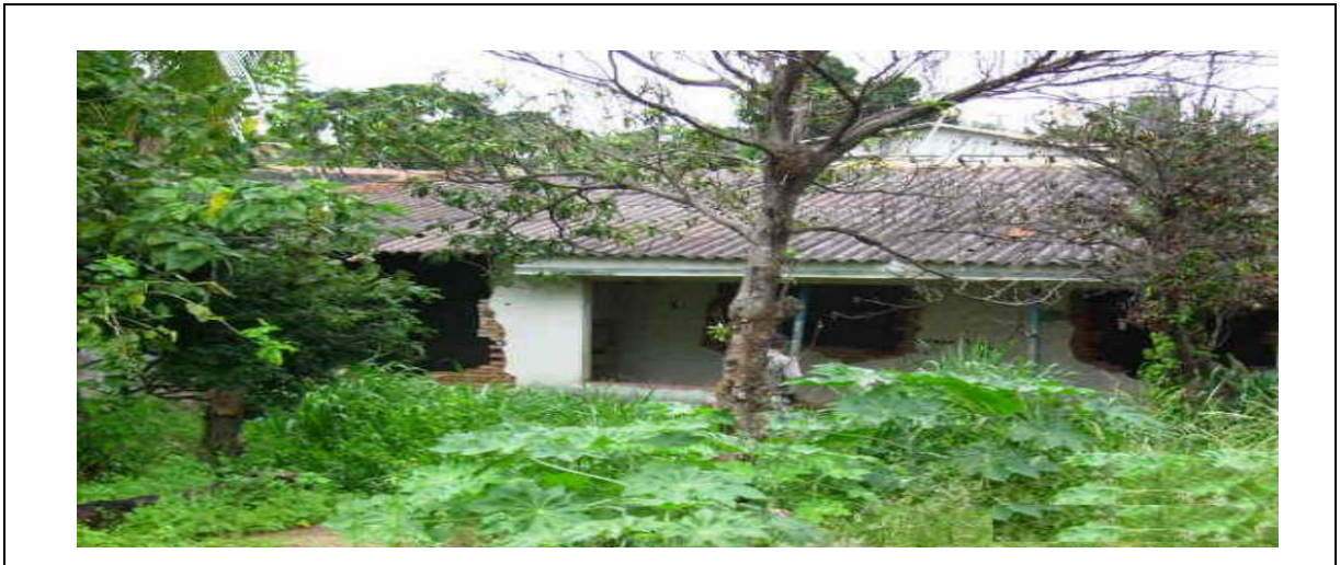
Figura 10: Casa abandonada. Rua 233 nº 830, Setor Universitário. Conforme averiguação está servindo como ponto de abrigo no período noturno por indivíduos moradores de rua.
