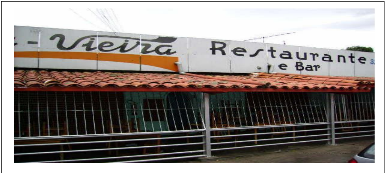
Figura 15: Prédio comercial abandonado. Rua 94 com a Rua 94-A nº 31, Setor Sul. No local funcionava um restaurante e bar e que o mesmo se encontra abandonado e sem funcionamento há sessenta dias. Conforme informações de moradores o local está sendo utilizado como abrigo por moradores de ruas e que tal situação está trazendo desconforto e sensação de insegurança.
