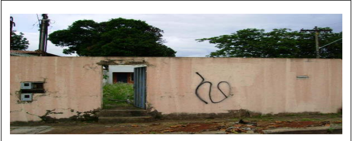
Figura 13: Casa abandonada. Rua 102 n° 141, Setor Sul. O local conforme informações de moradores da região é utilizado como ponto de consumo de drogas e abrigo no período noturno para menores moradores de rua, informo ainda que já foram encontrados materiais abandonados nesta residência.
