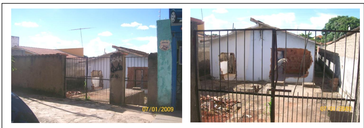
Figura 06: Casa abandonada. Av. Independência Qd. 70 Lt. 25 N° 3044, Setor Aeroporto. Casa abandonada que serve de abrigo para usuários de drogas e moradores de rua. Os vizinhos relatam que é frequente a presença de estranhos no local, durante a noite entram no imóvel e invadem os lotes vizinhos para furtar.
