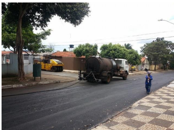
Figura 21 – Recapeamento asfáltico nas principais ruas, proveniente do PAC Mobilidade. Foto de 01/05/2015, CEDOC ASCA – Associação Caiçara
