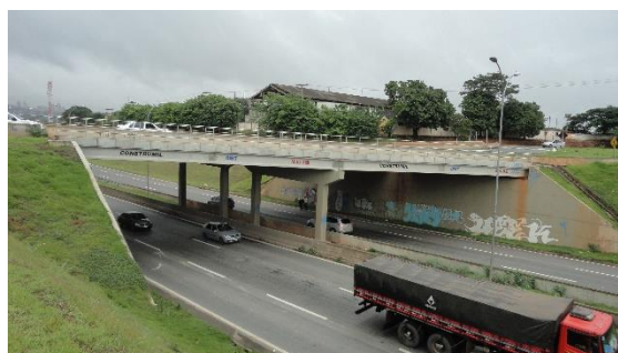
Figura 12 – Viaduto Caiçara, BR-153, resultado da mobilização liderada pela Associação. Foto de 21/01/2012, CEDOC ASCA – Associação Caiçara
