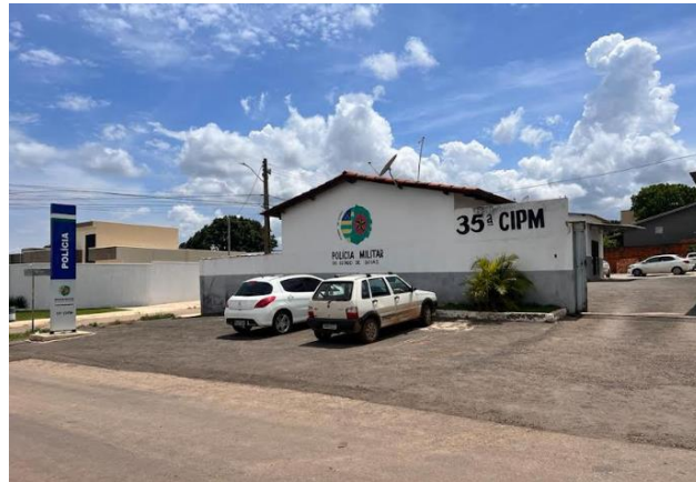
Figura 3 - Fachada da 35ª CIPM de Águas Lindas de Goiás
