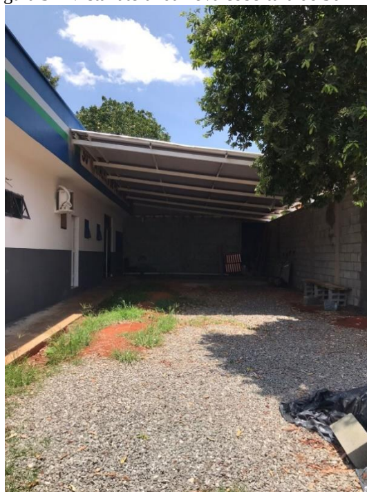
Figura 3 – Vista lateral da nova cobertura do 30º BPM
