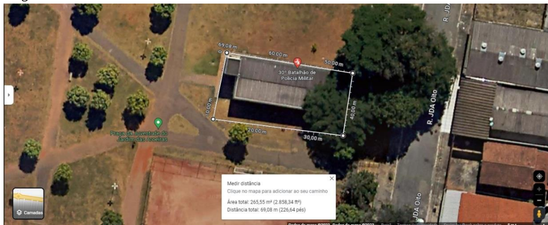
Figura 2 – Vista da cobertura do 30º BPM
