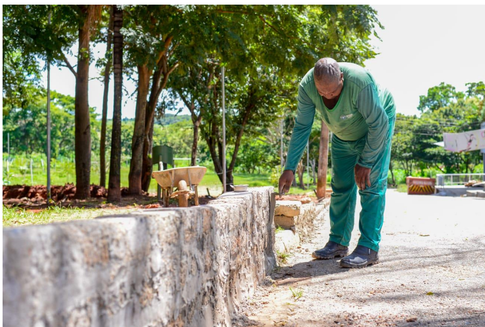
Foto 2- reforma nas calçadas, reparos na pista de caminhada, campo de areia, quadra de basquete e playground (Fonte: Site da Prefeitura de Goiânia)
