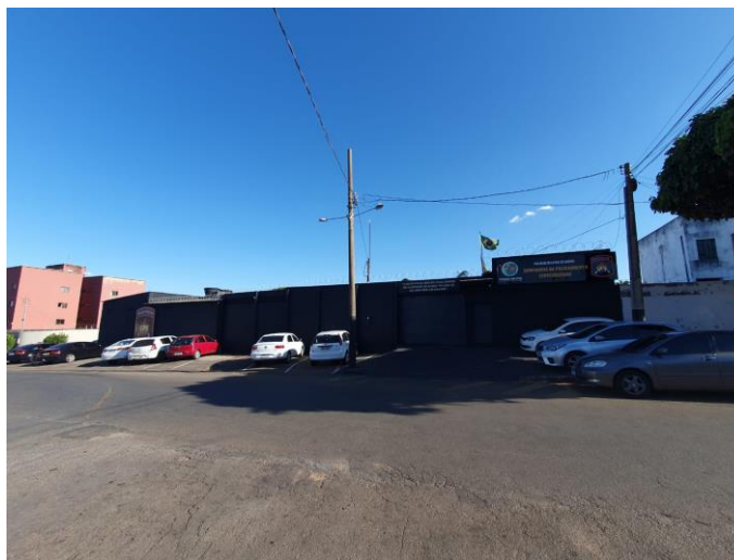
Figura 2 - Fachada da frente da CPE
