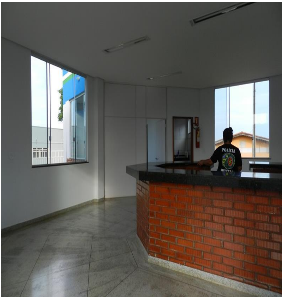
Figura 5: Interior da nova base da PMGO em São Simão. Nota-se ausência de preocupação com a segurança.
