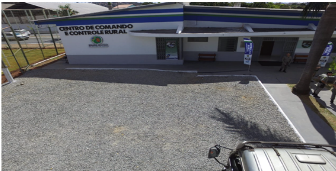
7.4 Fotografia da fachada antiga – antiga sede do BPMRural (Centro de Comando e Controle Rural)
