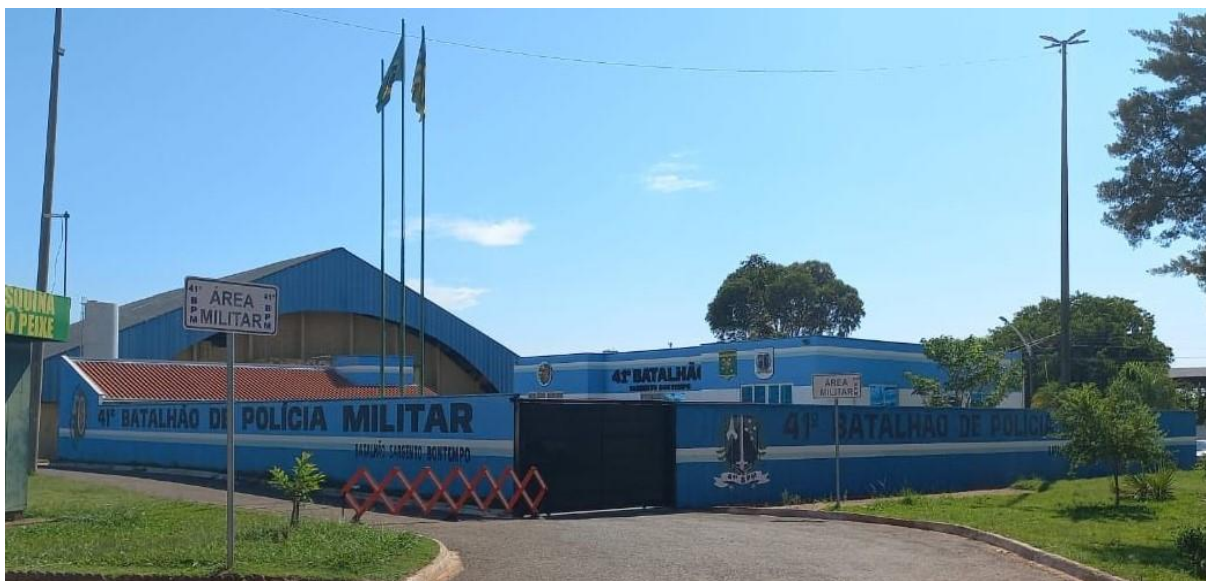
Figura 2 – Entrada do estacionamento das viaturas do 41º Batalhão da PMGO
