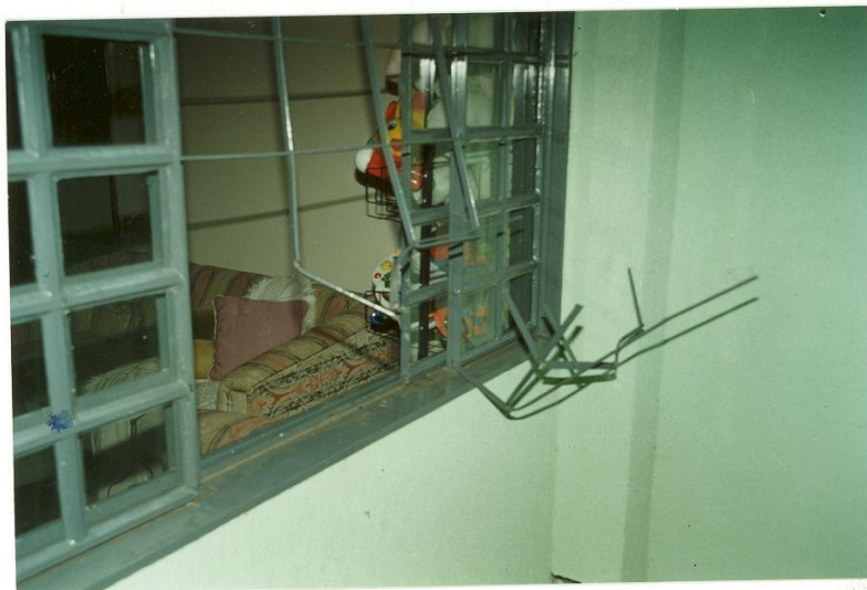
FOTO 01 – Janela dos fundos da casa: arrombamento com uso de instrumento do tipo alavanca, com rompimento de estrutura da grade de segurança;
